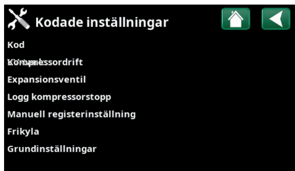
Meny "Avancerat/Service/Kodade inställningar".
